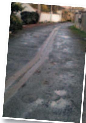
Chemin du Collège avant travaux
