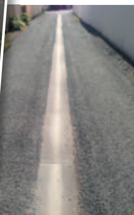
Chemin du Collège après travaux
